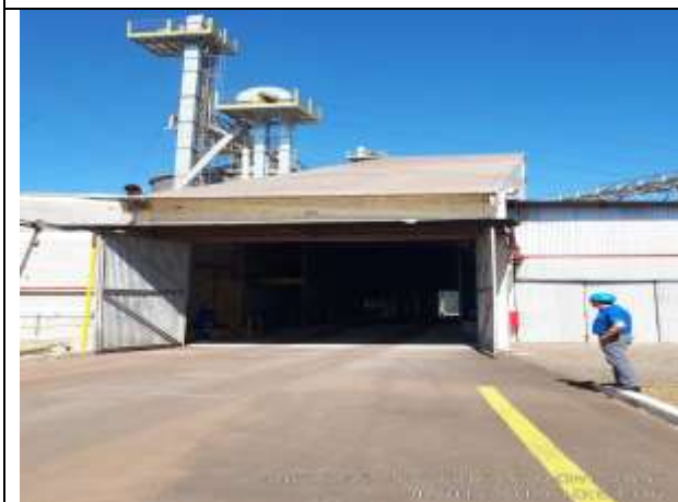
Sala de quadro de comando e do tombador
