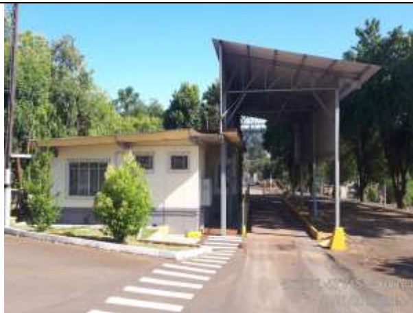
Cobertura da Balança
