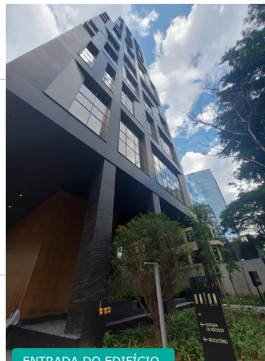
ENTRADA DO EDIFÍCIO
