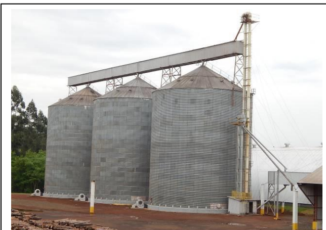
SILO METALICO PARA ARMAZENAGEM DE
