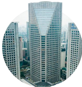
Ativo CENU Torre Oeste
