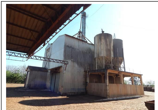
Vista das construções / Silos
