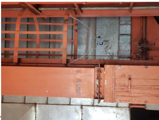
PAVIMENTAÇÃO E MEIO FIO
