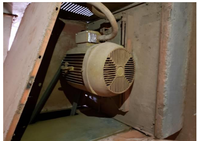
MOTOR WEG 40CV MOD. 200M TRIFÁSICO
